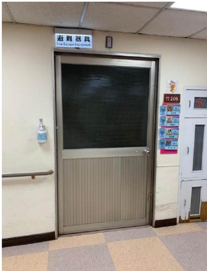
今年獲補助優先更換6、7樓的病房門升級為具有60分鐘防火時效的防火門(原始設計為防火玻璃配鋁門，具有30分鐘防火時效)
